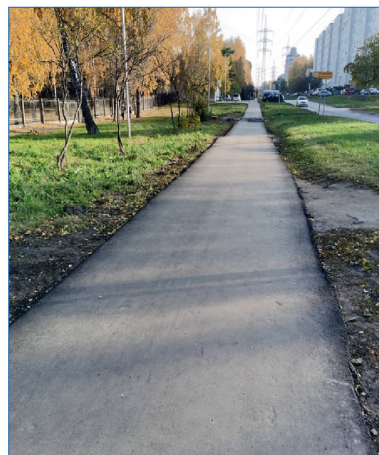
Ремонт тротуара по ул. Иванова
