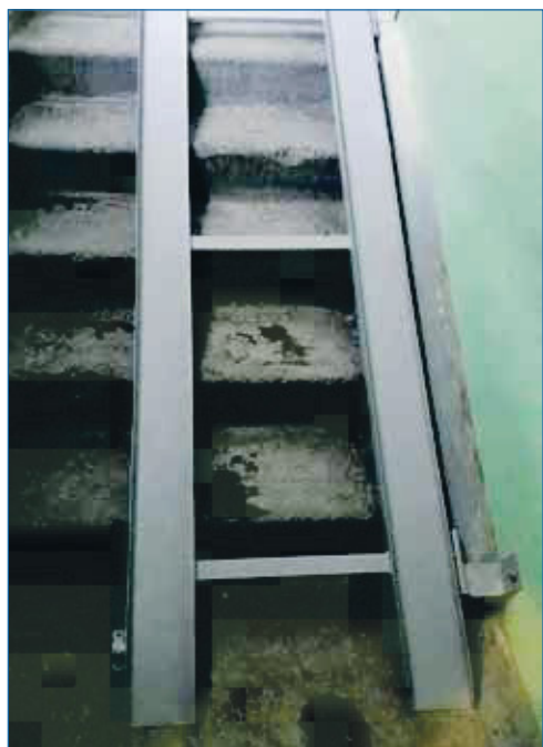
По обращению жителя округа с ограниченными возможностями здоровья в подъезде, где он проживает, смонтирован пандус
