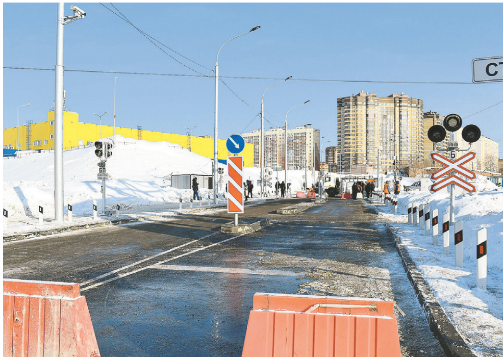
На округе активно ведется работа по строительству новых дорог
