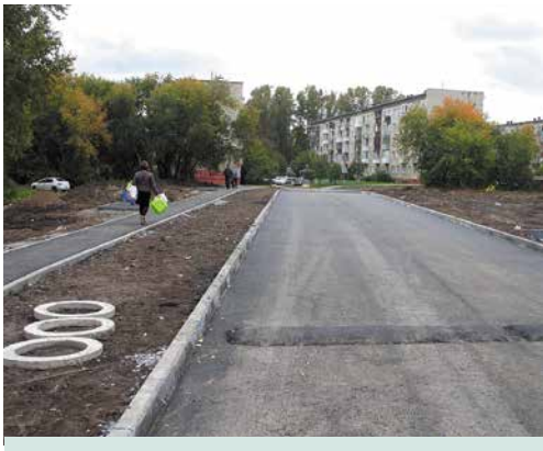
Место бывшего котлована благоустроено
