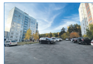
Экваторная, 11. Расширение парковки и ремонт внутриквартального проезда
