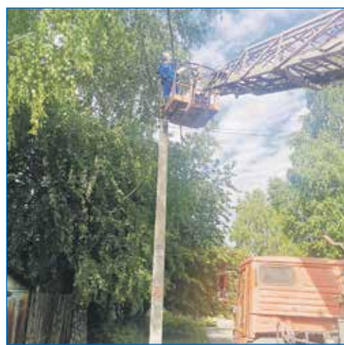
Монтаж новых ламп для уличного освещения
