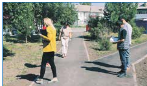
Проверка качества выполнения наказа — обустройства тротуара во дворах на улице Новоуральской
