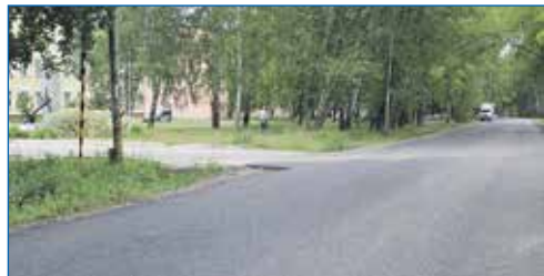
На улице Флотской уложили новый асфальт
