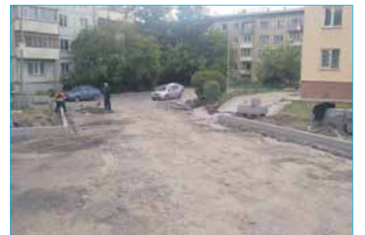
Ремонт асфальтового покрытия проезда к дому 101/1 по ул. Выборная
