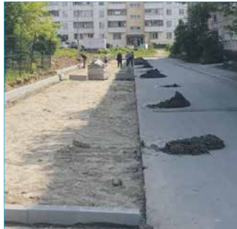
Строительство парковочного кармана, Ключ-Камышенское плато, дом №119
