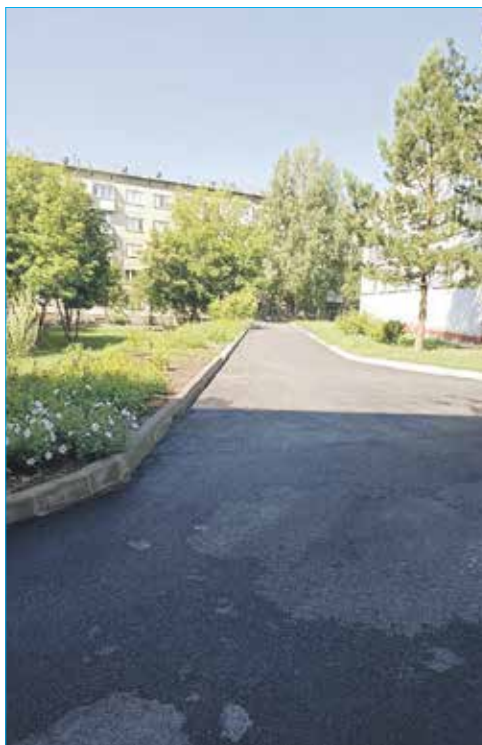
Асфальтирование у школы №206
