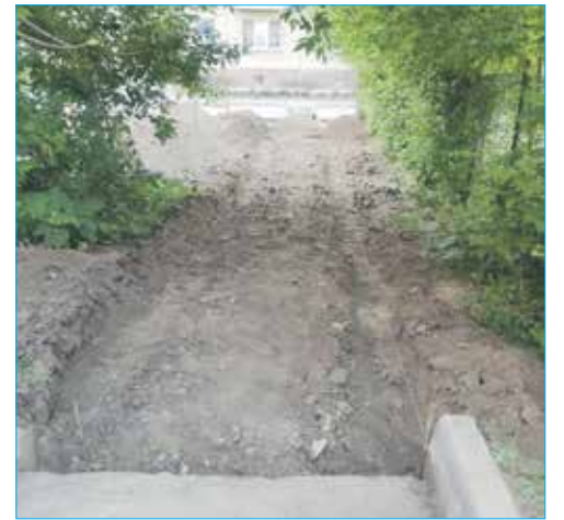
Строительство тротуара между домами 119 и 131 на Ключ-Камышенского плато
